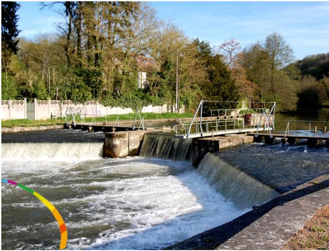
Le pertuis à aiguilles permet de maintenir un niveau d'eau suffisant dans l'Yonne. Pendant le flottage, il permettait d'arrêter les bûches venant du Morvan et assurait « les éclusées » (crues artificielles) indispensables à la navigation. Il a été déplacé au début du XX<sup>e</sup> siècle, lorsque le canal a été dérivé par l'Yonne et l'écluse des Jeux construite.
